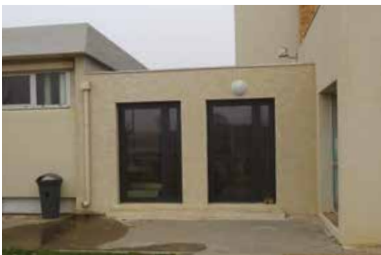
Création d'une salle des maîtres
